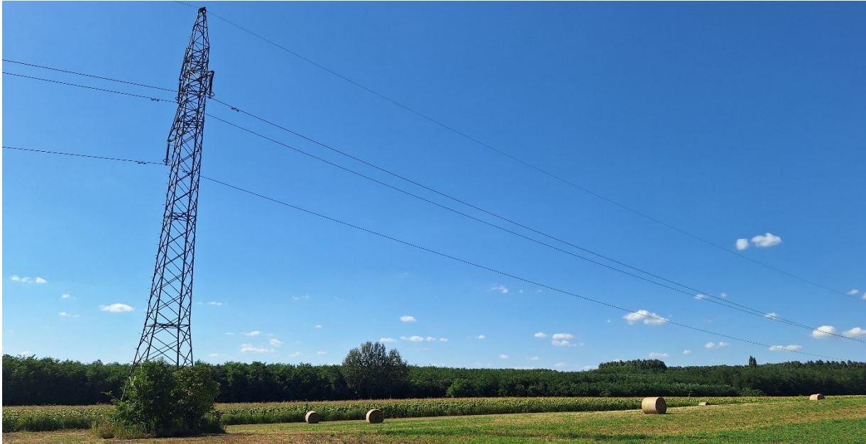
A 0194/16 hrsz.-ú telket keresztező 132 kV-os nagyfeszültségű elektromos távvezeték ÉNy-i irányban
