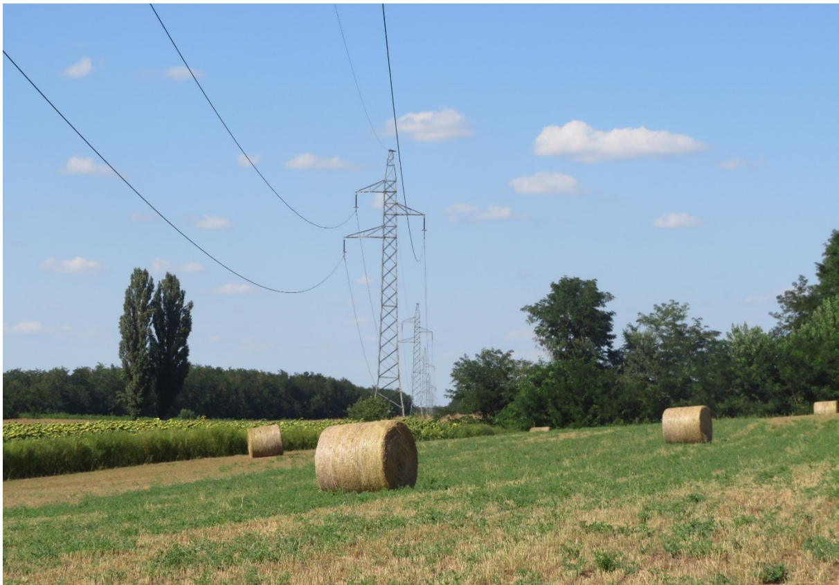
A tervezési területet keresztező nagyfeszültségű elektromos távvezeték ÉNy-i irányban
