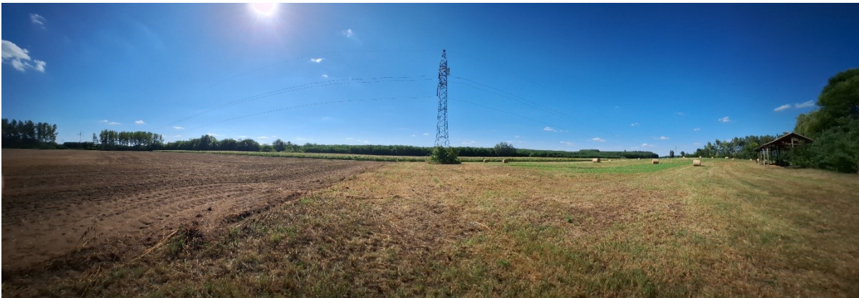
A 0194/16 hrsz.-ú telket keresztező nagyfeszültségű elektromos távvezeték panoráma látképe
