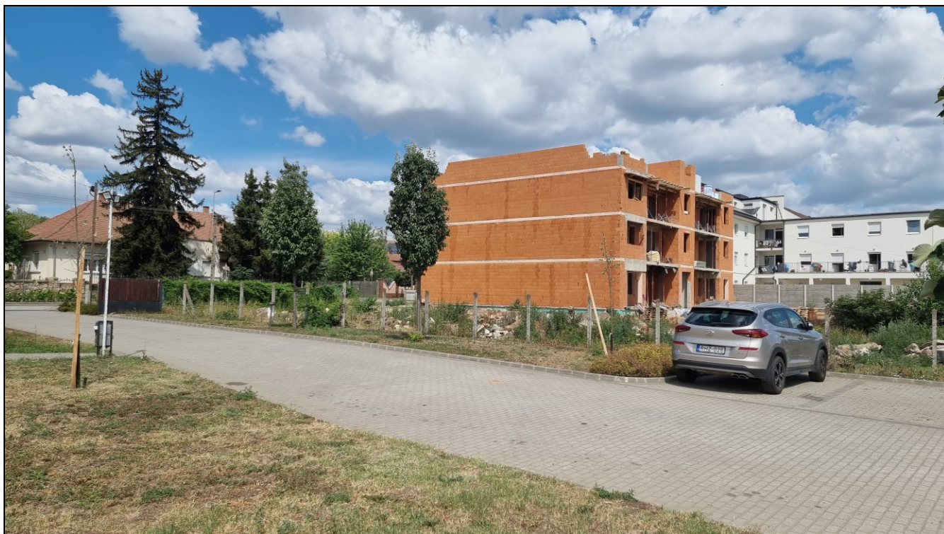
5 hrsz-ú ingatlan a 4 hrsz-ú ingatlanról. Forrás: Saját fotó
